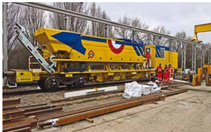
1. Consegna al deposito di Ruislip
