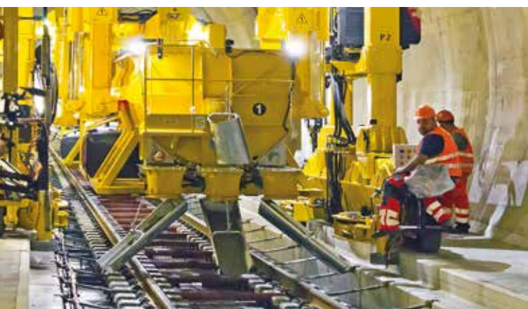
1. Lo scarico del calcestruzzo nel tunnel Monte Ceneri per GCF SpA per il collegamento Alta Velocità Milano-Zurigo
