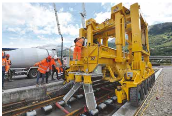
11. Il terminale di scarico messo a punto per il cantiere del tunnel di base del Monte Ceneri ha dimostrato un'efficienza molto elevata permettendo i getti senza dover proteggere i binari
